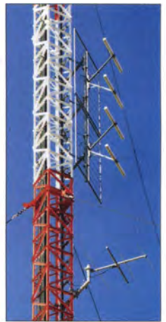
Bild 7: Nahaufnahme der Dipolgruppe und einer von zwei Yagi-Antennen
