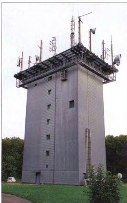
Bild 9: Die Sendestelle Weimar-Ettersberg ist bestens geeignet für Abstrahlungen mit quasi-optischer Ausbreitung. Im Turm befinden sich Sender für Richtfunk, Analog-UKW, DAB, DAB+ und DVB-T. Das Amateurfunk-Relais DB0ETB hat ebenfalls einen Platz gefunden. Die Antennenplattform mit 120 m 2 Fläche bietet nicht mehr viel Reserve.
