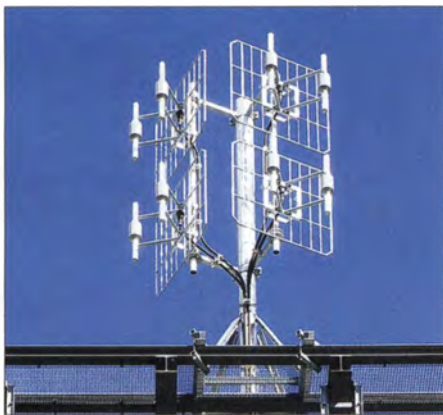
Bild 13: Gestockte Dipole mit Reflektor für DAB+
