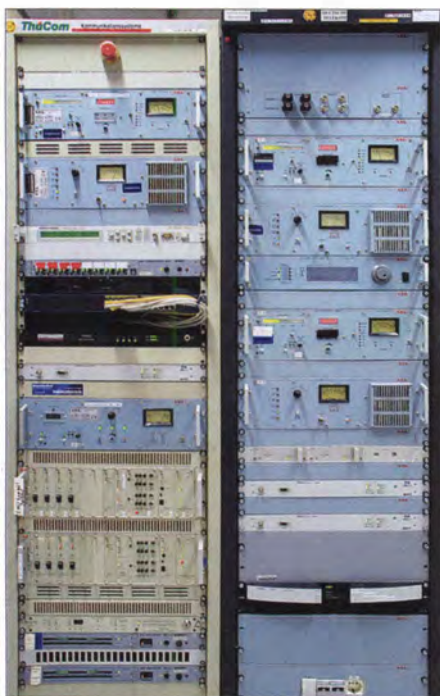
Bild 8: UKW-Sender und Steuereinrichtungen in Weimar Belvedere
