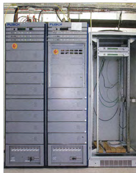
Bild 10: Zwei Sender für DAB+ im Sendeturm Weimar-Ettersberg; rechts zwei Satelliten-Empfänger
